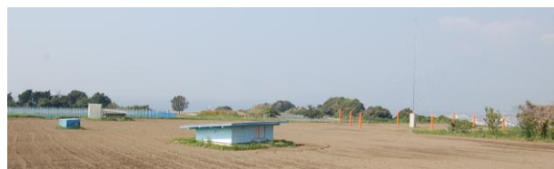
ELF/VLF 受信アンテナと地磁気観測小屋。
